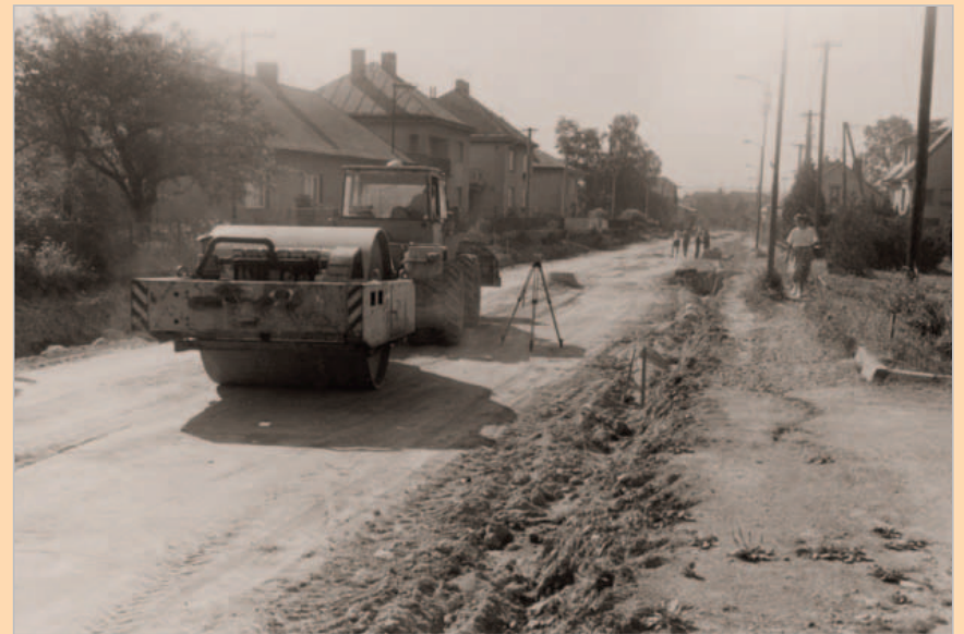
1986 – oprava silnice na Chrudimské ulici
