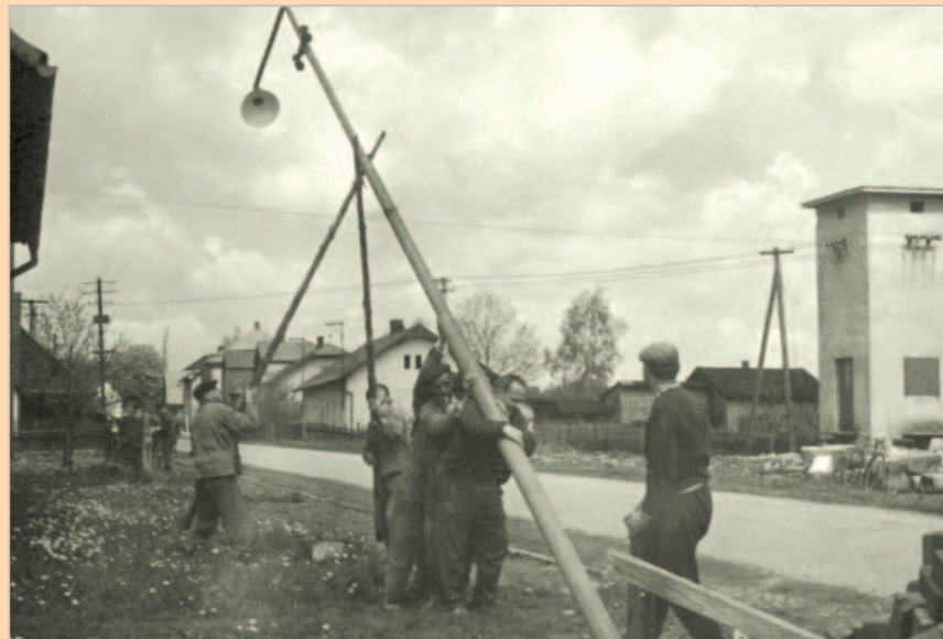
1979 – budování veřejného osvětlení
