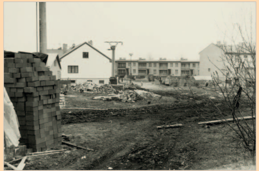
1987 – výstavba řadových domů u hřiště
