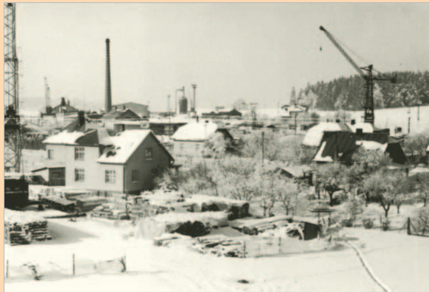
1976 – staveniště bytovky čp. 405
