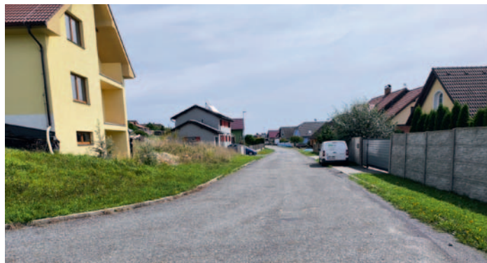
Místní komunikace v ulici V Údolí před stavební úpravou
