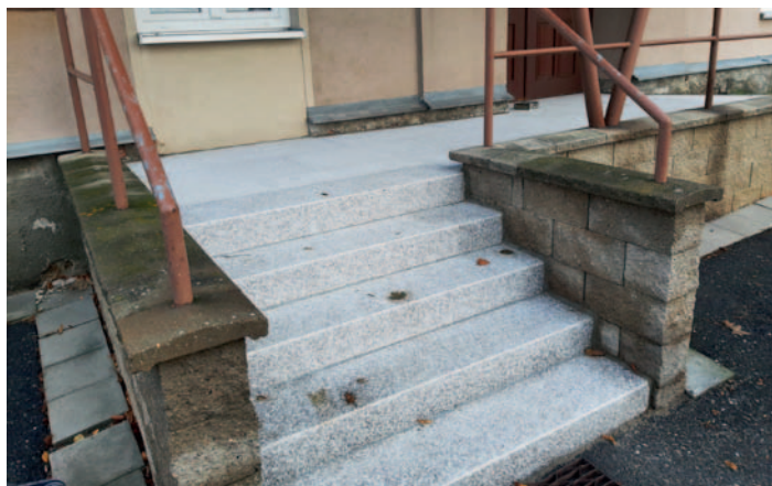
Zrekonstruované schodiště v Údavech u obecního domu
